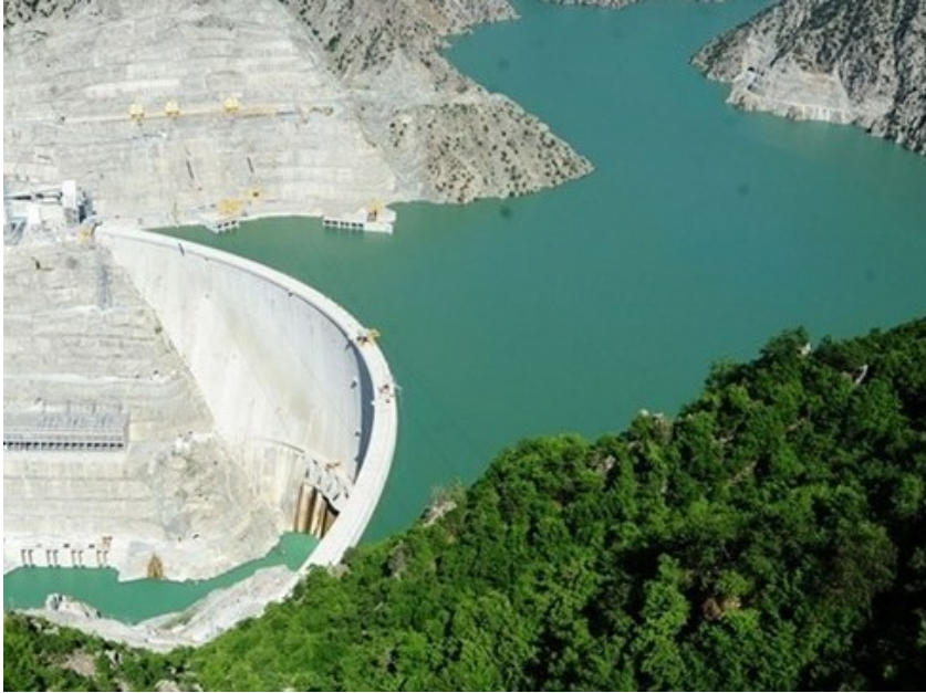
Türkiye’nin en yüksek ve dünyanın 13. yüksek barajı olan Deriner Barajı (çift eğrilikli beton kemer baraj)
